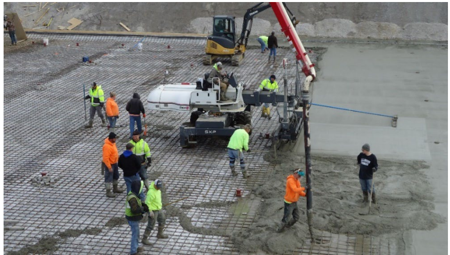
Concrete pour on floor of Basin - SWWTP
